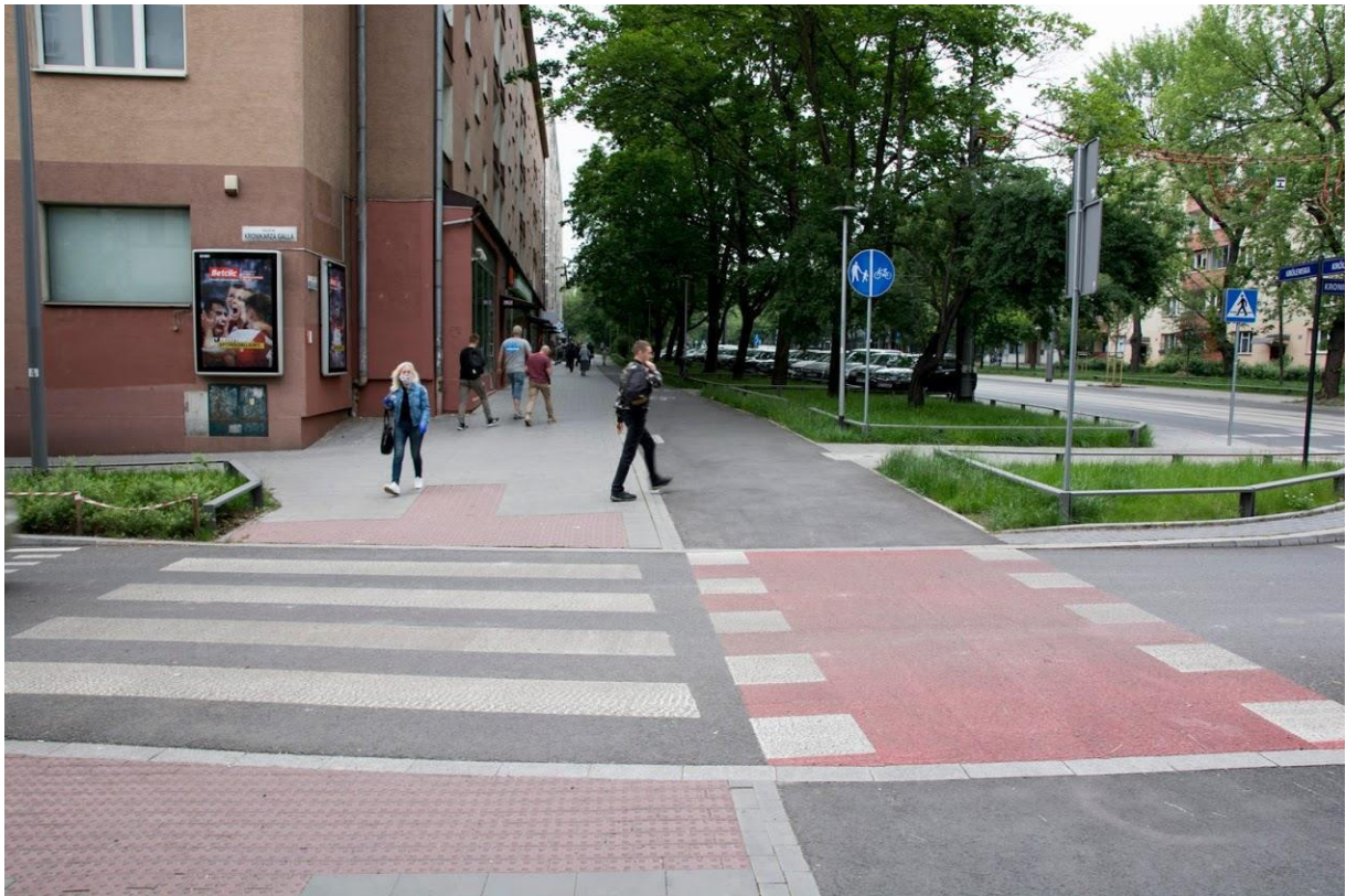
Zdjęcie 13. Przejście dla pieszych oraz przejazd dla rowerzystów na wyniesionym progu na wlocie ulicy (Kraków)
