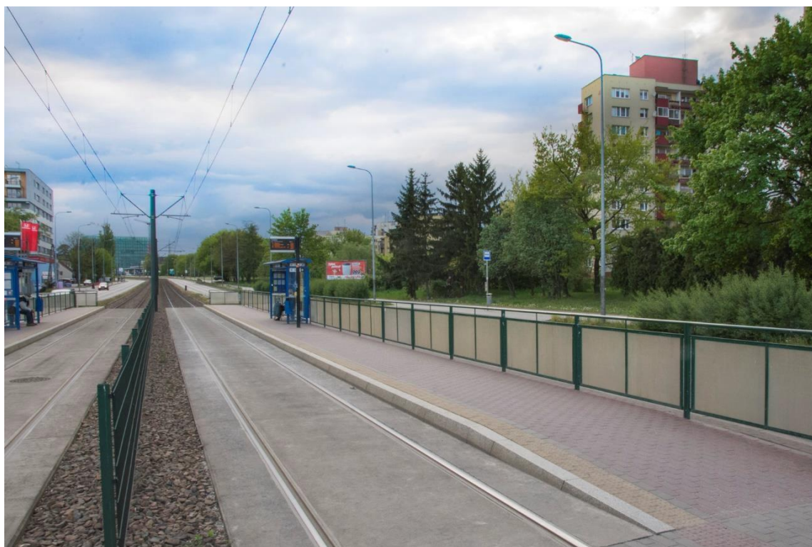
Zdjęcie 21. Wydzielony przystanek tramwajowy (Kraków)
