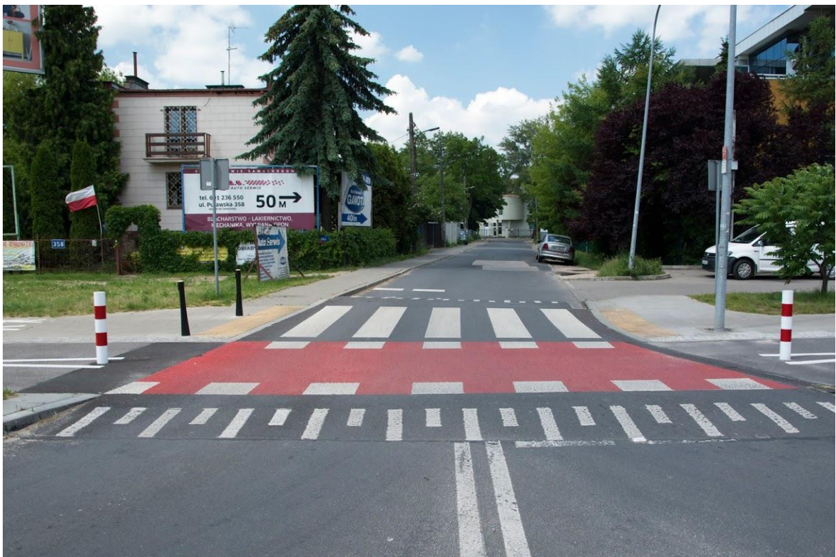
Zdjęcie 14. Przejście dla pieszych i przejazd dla rowerzystów na wyniesionym progu na wlocie ulicy (Warszawa)
