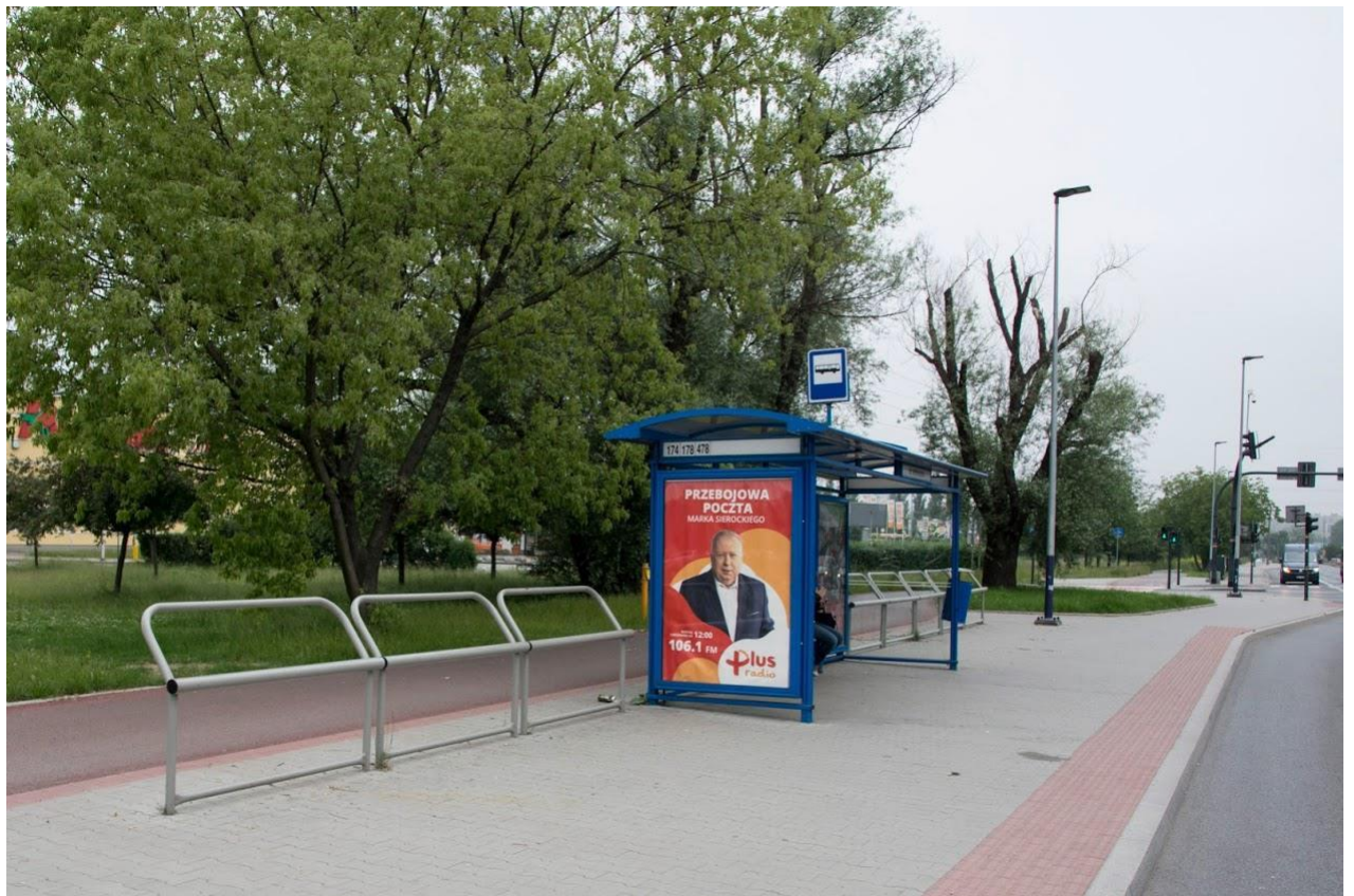
Zdjęcie 19. Oddzielenie ruchu rowerowego od przestrzeni peronu przy pomocy wygrodzeń z podpórkami (Kraków)
