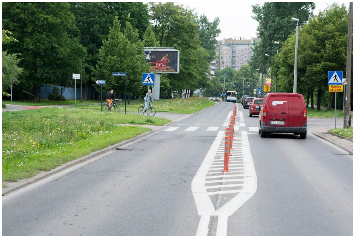
Zdjęcie 12. Zawężenie jezdni bez azylu (Kraków). Takie rozwiązania są uzasadnione w sytuacji, kiedy niemożliwa jest szersza przebudowa jezdni
