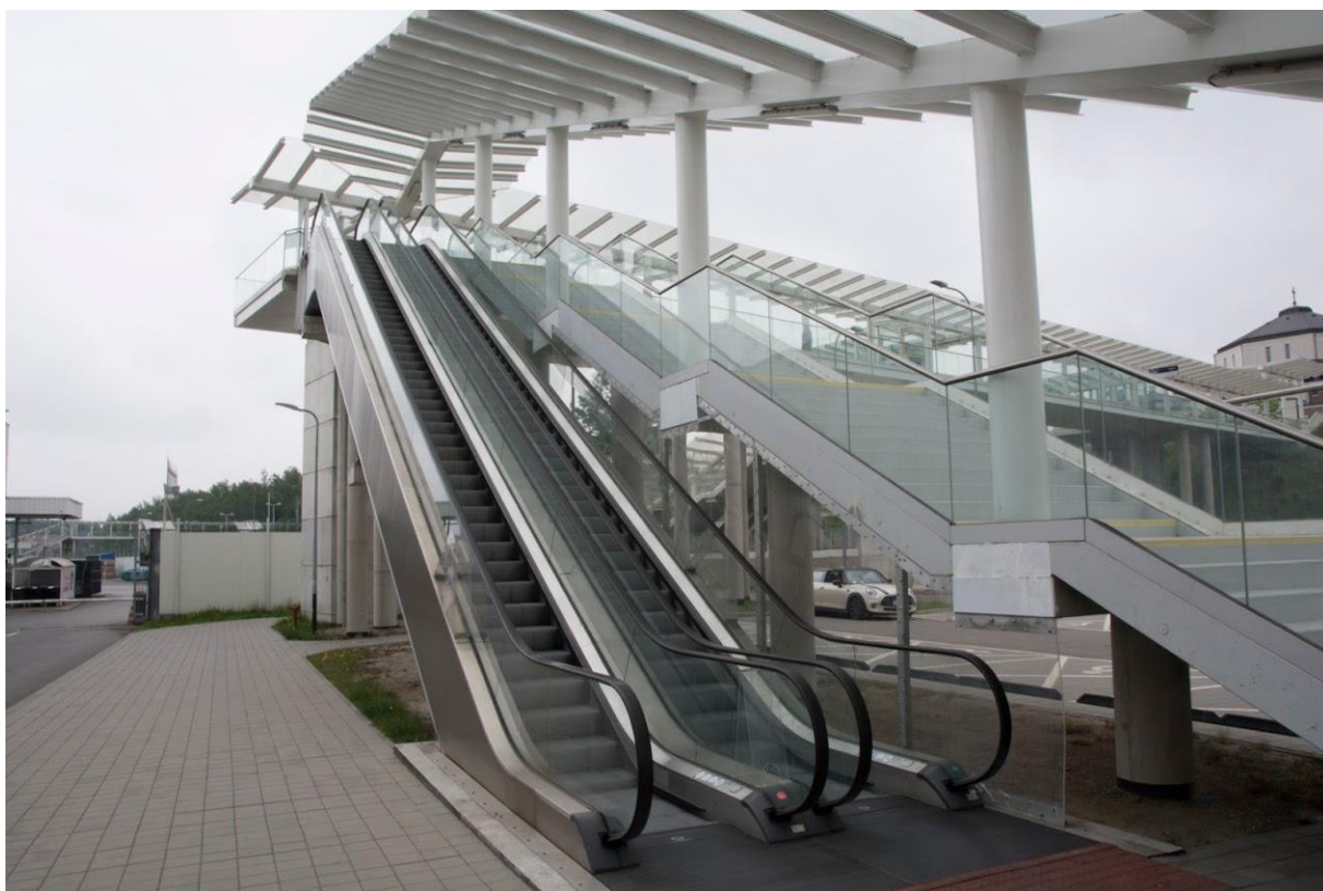
Zdjęcie 25. Schody ruchome oraz zwykłe w ramach przejścia nad torami kolejowymi (Kraków)
