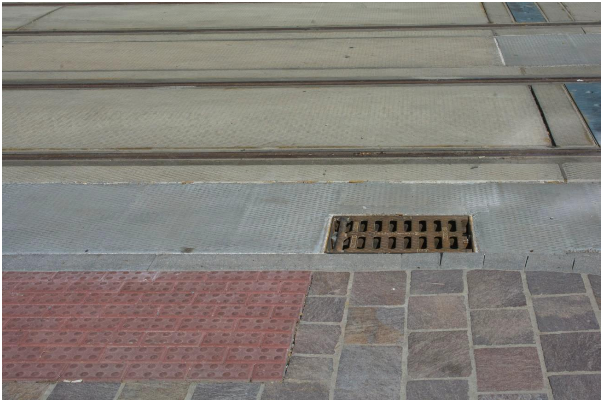
Zdjęcie 16. Kratki ściekowe należy umieszczać poza przejściem jednak w bezpośredniej jego bliskości (Kraków).
