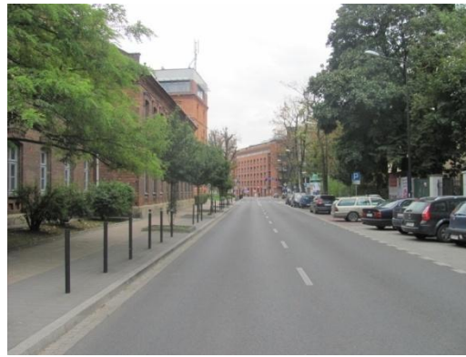
Zdjęcie 7. Przebudowana ul. Szlak
