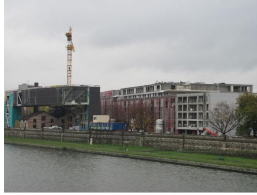
Zdjęcie 13. Budowa Muzeum Tadeusza Kantora
