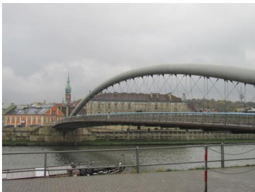
Zdjęcie 10. Kładka pieszo-rowerowa przez Wisłę – „O. Bernatka”
