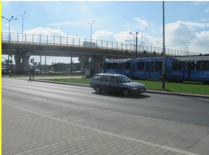
Zdjęcie 26. Dwupoziomowe skrzyżowanie ul. Nowohuckiej z ul. Kuklińskiego/ Surzyckiego
