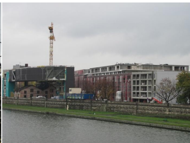
Zdjęcie 13. Budowa Muzeum Tadeusza Kantora
