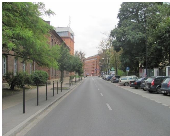
Zdjęcie 7. Przebudowana ul. Szlak
