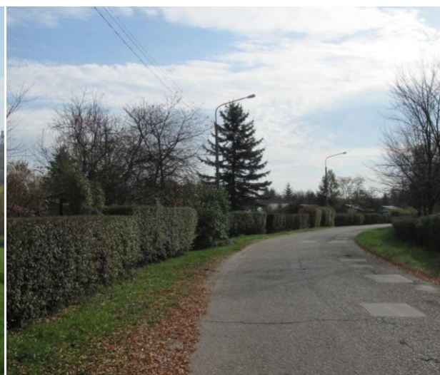
Zdjęcie 2. Przykład zdegradowanej nawierzchni ulicy wewnątrz obszaru.
