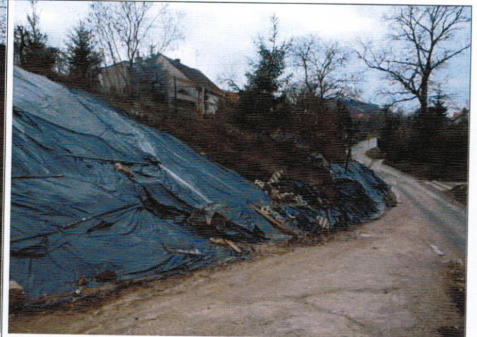
Zerwanie ogrodzenia posesji nr 51 na działce nr 82
