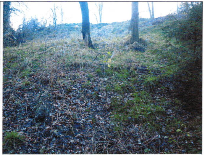
Koluwia na terenie osuwiska „a” i jego czoło
