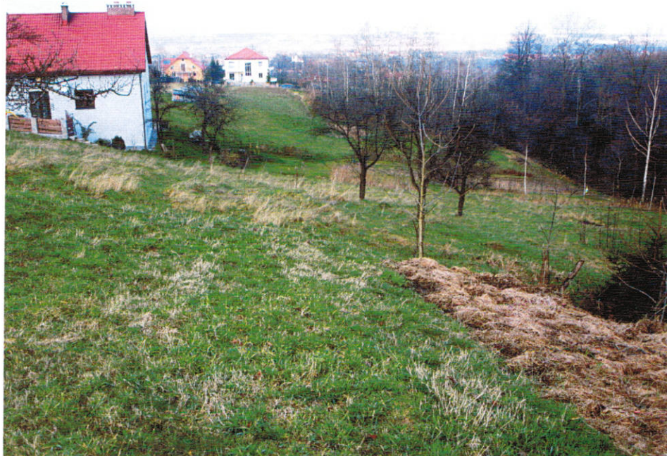
Nieczynne osuwisko „c”, widoczna skarpa boczna ograniczająca osuwisko od północy
