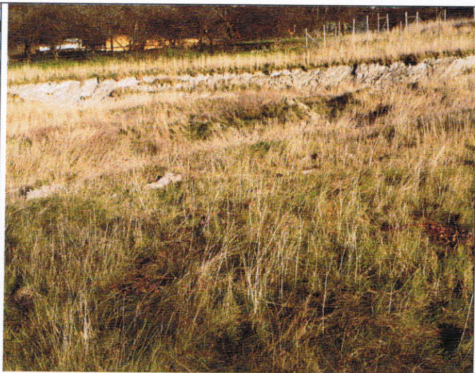
Skarpa boczna w środkowej części osuwiska
