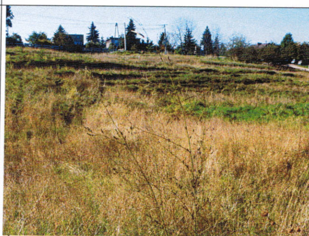
Środkowa część osuwiska – widok z dołu
