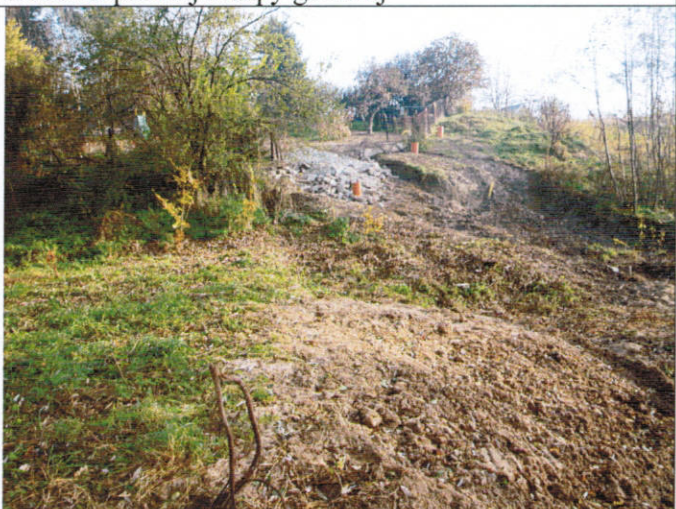
Odwodnienie na osuwisku 346/6 i dz. 345/1
