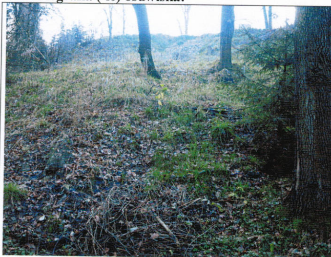
Osuwisko „a” – skarpa główna
