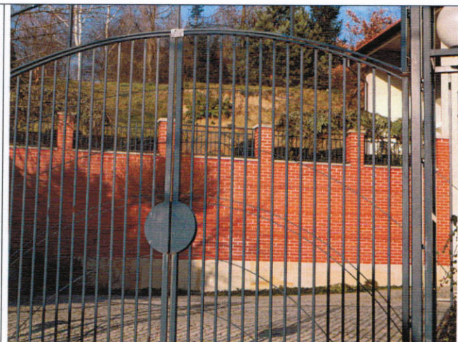
Zerwanie gruntów ponad budynkiem mieszkalnym Kamedulska 21
