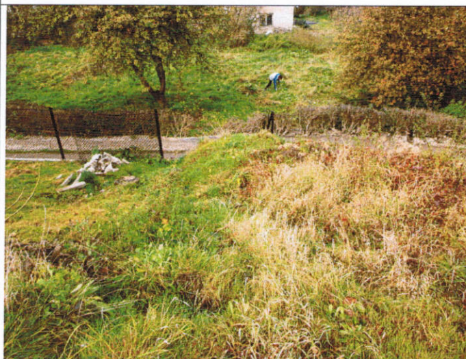
Widok na osuwisko od strony skarpy głównej
