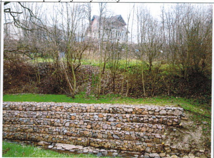
Początek zabezpieczenia od południa
