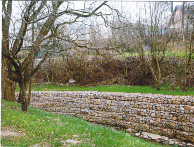
Zabezpieczenie przeciwozyjne wzdłuż prawostronnej części koryta Drwinki
