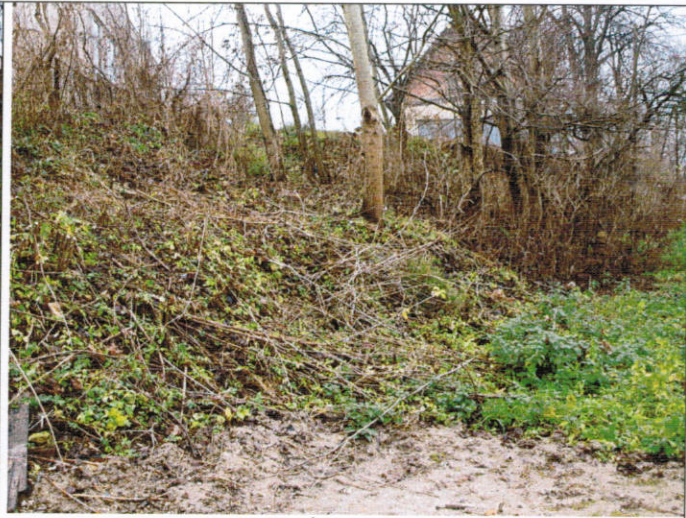
Osuwisko powyżej ulicy Żabiej
