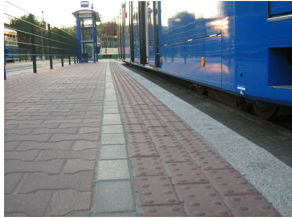
Fot. 11-12. Oznaczenie krawędzi peronu przystankowego, pasem o zróżnicowanej kolorystyce i fakturze.
