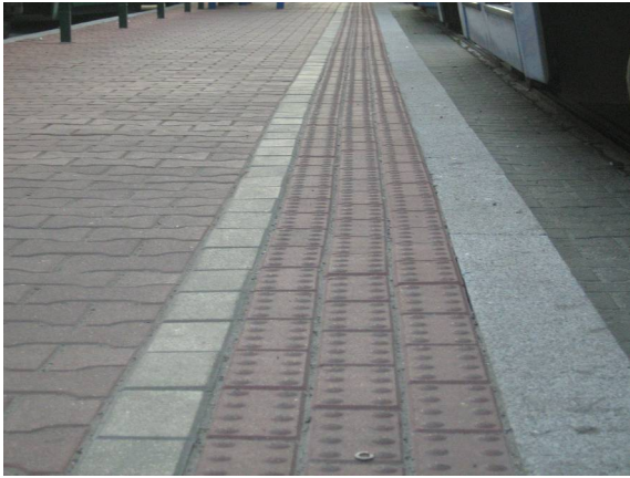
Fot. 11-12. Oznaczenie krawędzi peronu przystankowego, pasem o zróżnicowanej kolorystyce i fakturze.
