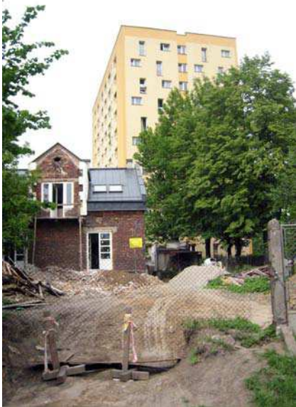
Fragment zabudowy osiedla Azory
