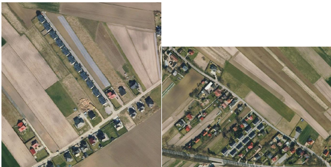
Fot. 15 Zabudowa dysharmonijna przy ul. Stary Gościniec oraz przy ul. Kantorowickiej, zamykająca połączenia ekologiczne [42].
