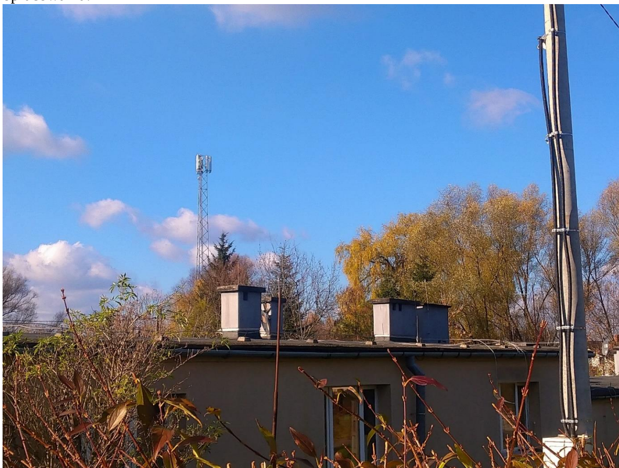
Fot. 11 Widok na maszt telefonii komórkowej przy ul. Zakole - poza obszarem opracowania.
