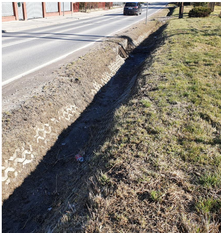
Fot. 2. Rów odwadniający wzdłuż ul. Rząckiej.
