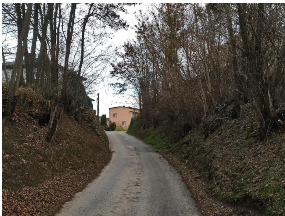
Fot. 1. Strome skarpy przy ul. Zakole.
