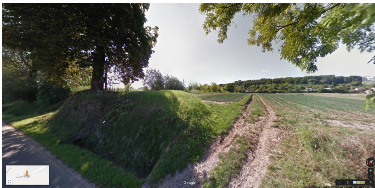
Fot. 4. Widok na przydrożną kapliczkę, mogącą ulec likwidacji w przypadku realizacji wariantu W2. Źródło gogle.pl/maps dostęp kwiecień 2019r [43].
