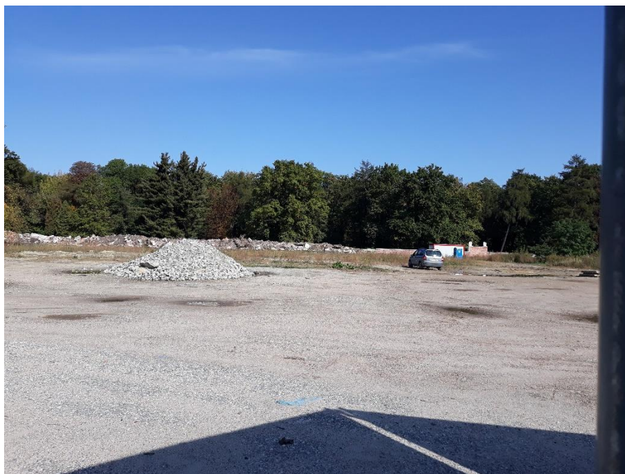
Fot. 1. Tereny MW/U.3, U.3 – stan październik 2019r.
