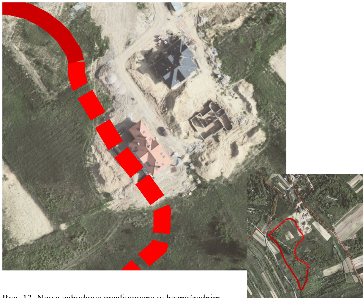
Ryc. 13. Nowa zabudowa zrealizowana w bezpośrednim sąsiedztwie osuwiska (granica osuwiska (nr 2/4) na podst. Map dokumentacyjnych osuwisk i terenów zagrożonych ruchami masowymi [23] na tle ortofotomapy z roku 2013)
