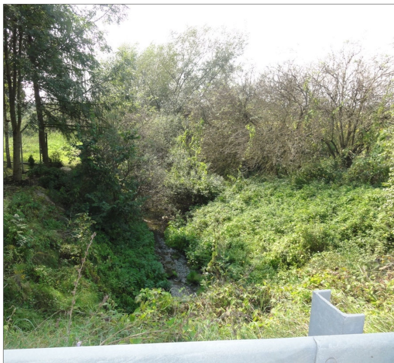
Fot. 2. Potok Sudół w rejonie skrzyżowania z ul. Łokietka (obszar „Tonie Północ”).
