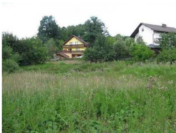
Fot.2.14. Obiekt mieszkalny na osuwisku wyłączonej z użytkowania ze względu na zagrożenie. Po prawej u góry – wyłączony obiekt, skarpa osuwiska - po prawej w środku, tablica ostrzegawcza – po prawej u dołu. Po lewej panorama terenu ponad wyłączonym obiektem.
