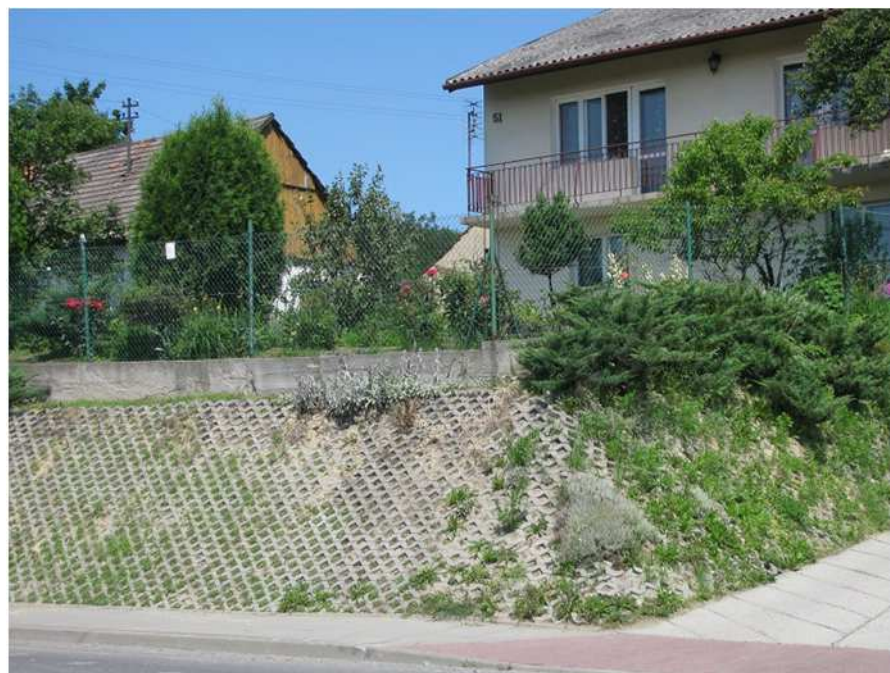
Fot.2.17. Umocnienie skarpy, poniżej znajduje się stok osuwiskowy, Soboniowice (fot. J. Kowalczyk).
