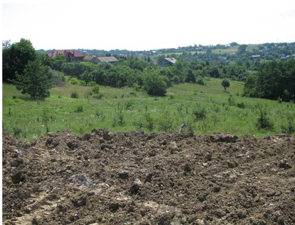
Fot.2.16. Zdjęcie zrobione z terenu budowy, poniżej stoki osuwiskowe, Soboniowice (fot. J. Kowalczuk).
