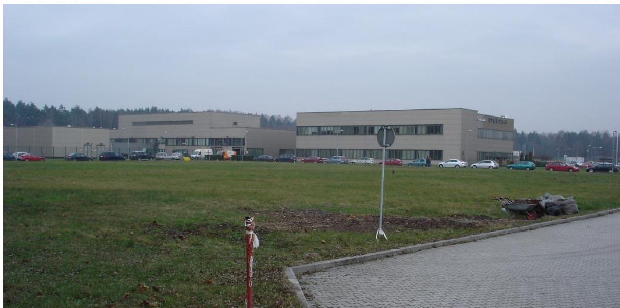
Fot. 4. . Widok na Centrum Techniczne „Delphi” znajdujące się na obszarze planu (fot. Grzegorz Słoński).
