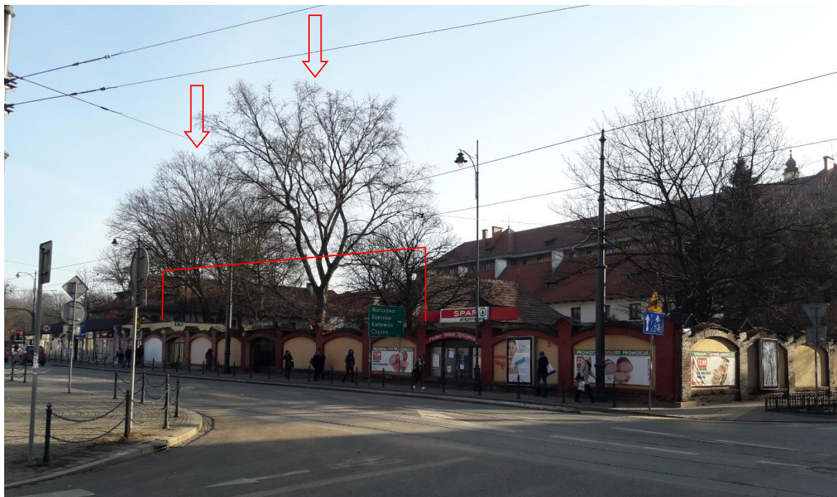
Fot. 10. Możliwa zmiana w otoczeniu Nowego Kleparza – budowa budynku usługowego (wys. maks. 13m), usunięcie/redukcja istniejących drzew.
