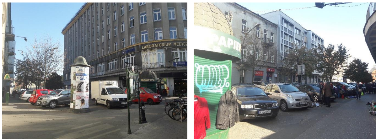
Fot. 6. Przestrzeń pomiędzy ulicą Basztową a Starym Kleparzem - planowany teren placu miejskiego (KP.1) (stan 2017r.)
