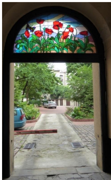
Fot. 9. Witraż w bramie wejściowej na podwórko w kamienicy Przy ulicy Basztowej.
