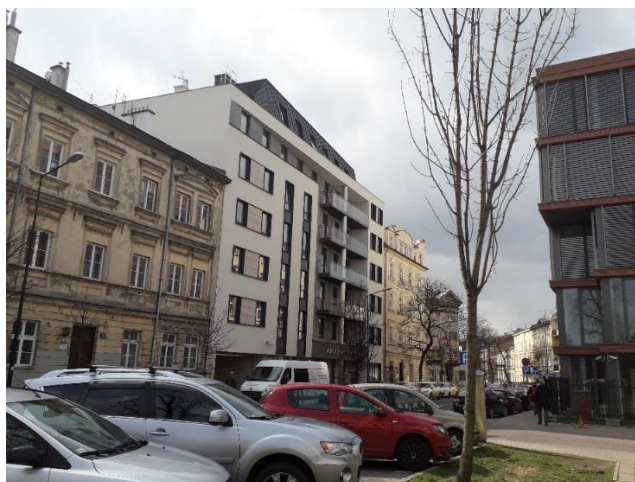
Fot. 3. Wypełnienie luki pierzei zabudowy przy ulicy Szlak (ul. Szlak 49) (stan: marzec 2019r.)
