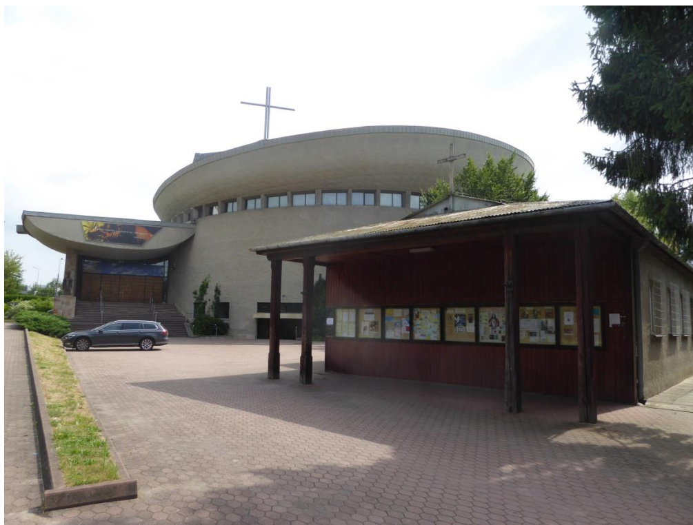
Fot. 1. Kościół św. Jana Kantego w Krakowie, widok na fragment południowo-wschodniej elewacji. Na pierwszym planie znajduje się budynek kaplicy, funkcjonującej w czasie budowy kościoła. (fot. Pracownia Urbanistyczna BPP, lipiec 2019 r.)
