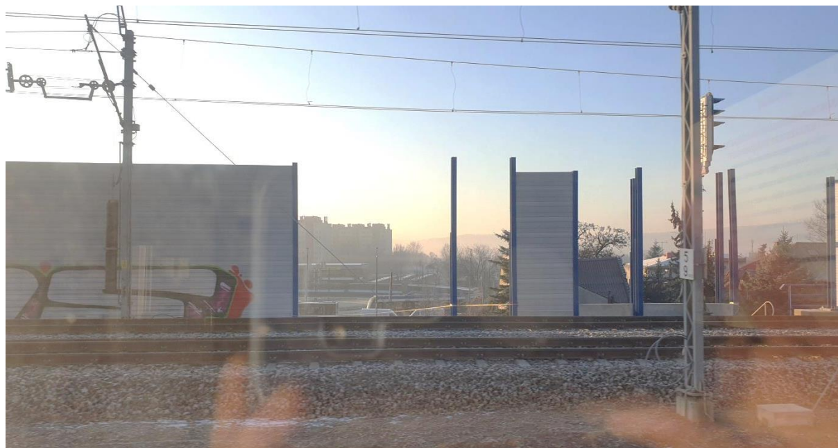
Fot. 10 Realizacja ekranów akustycznych po północnej stronie zabudowy zlokalizowanej przy ul. Balickiej. Widok w kierunku południowym, widoczny fragment pętli tramwajowej, fragment zabudowy wielorodzinnej osiedla i powiązanie widokowe ze wzgórzem Sowińca.
