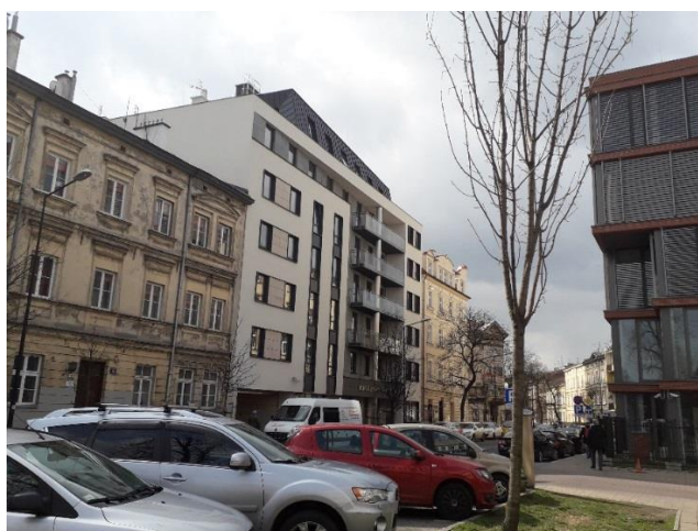
Fot. 3. Wypełnienie luki pierzei zabudowy przy ulicy Szlak (ul. Szlak 49) (stan: marzec 2019r.)
