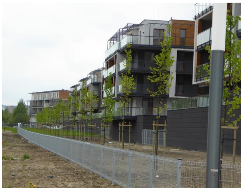
Fot. 9. Zabudowa nowego osiedla mieszkaniowego.
