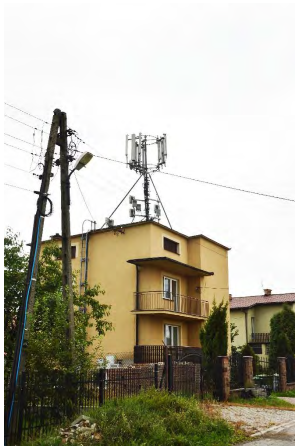
Fot. 22 Budynek ze stacją przekaźnikową telefonii komórkowej.
