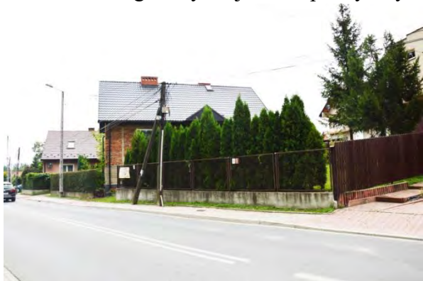
Fot. 14 Budynek mieszkalny z wymienionym dachem.
