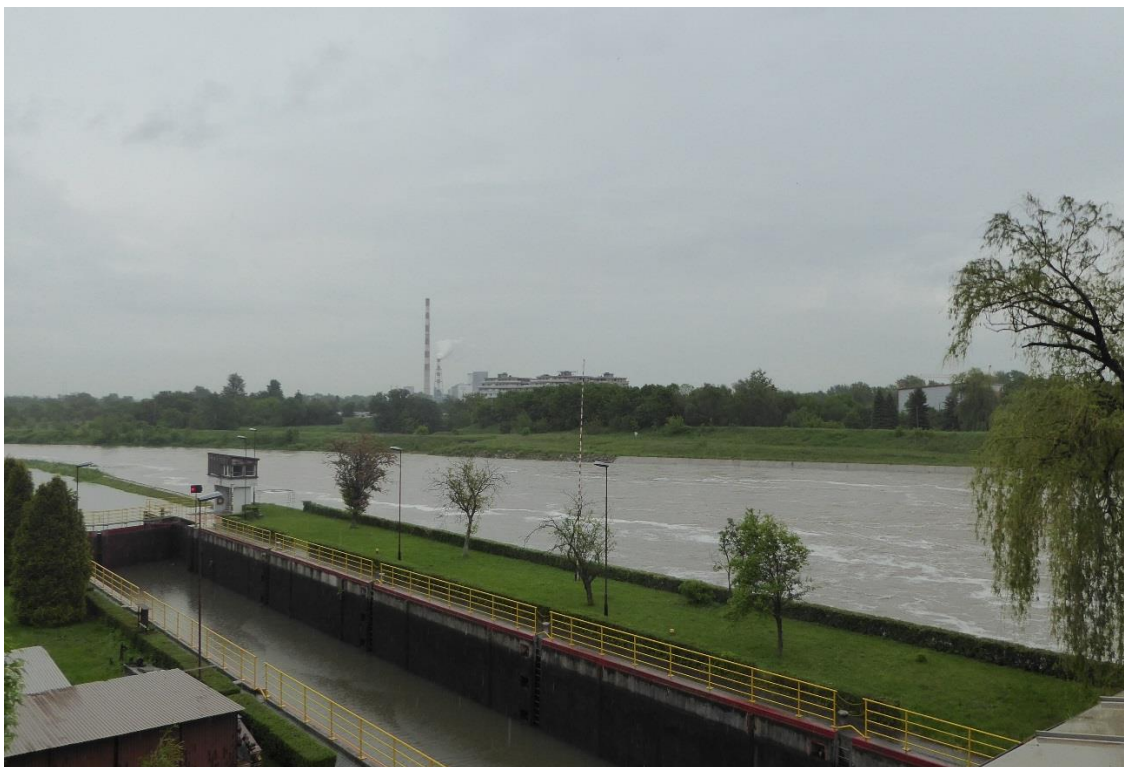
Fot. 1. Widok ze stopnia wodnego Dąbie, w części centralnej zabudowa przy ul. Na Zakolu Wisły (maj, 2019r.).
