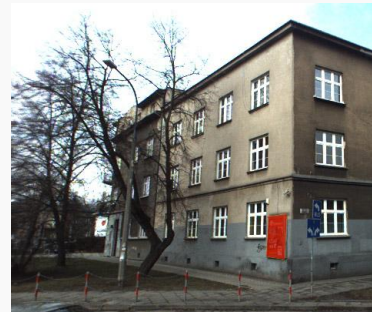
Reklama umieszczona na fasadzie parteru
