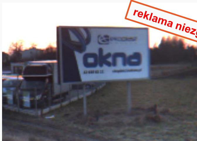
P009 – odległość dolnej krawędzi billboardu od ziemi poniżej 3m
