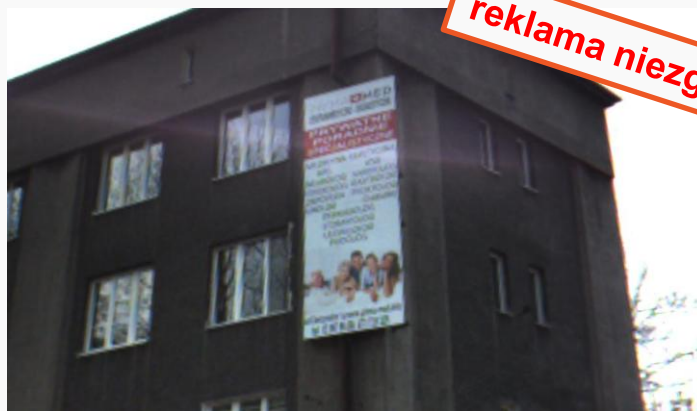
W581 – poza poziomem parteru
