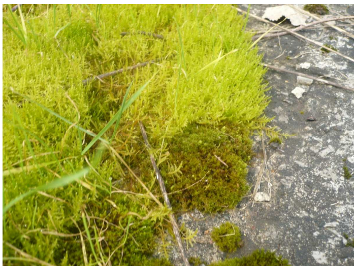
Fot. 3. Zarastające mchem i trawą betonowe płyty.
