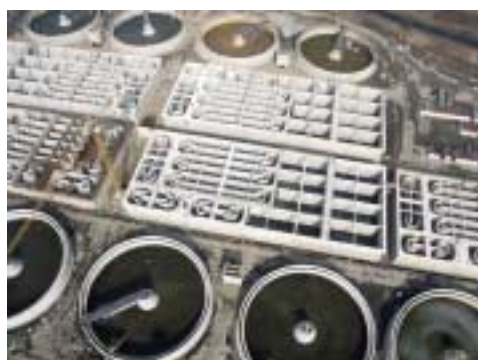
← Oczyszczalnia ścieków w Płaszowie
