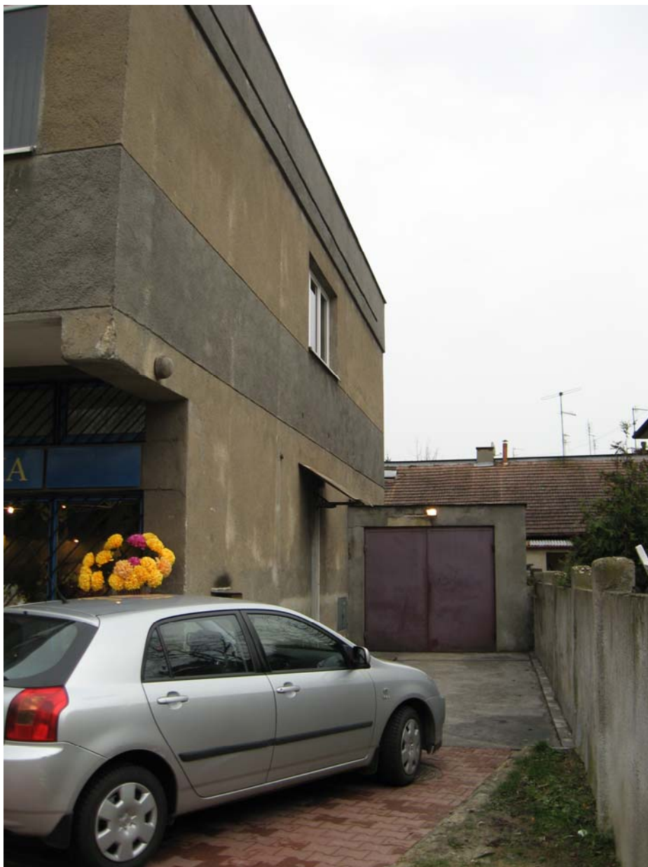
Zdjęcie nr 7. Widok na elewację południową.
