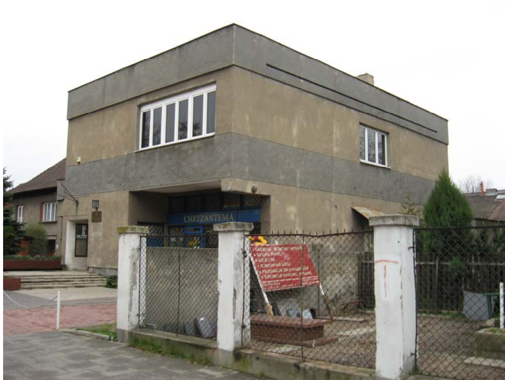
Zdjęcie nr 6. Widok na elewację południową.
