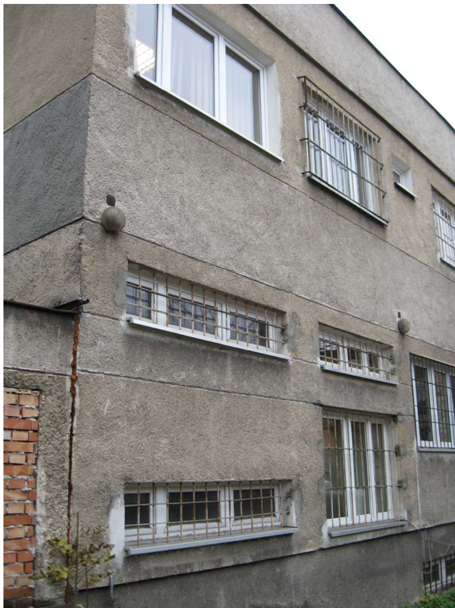
Zdjęcie nr 3. Widok na elewację wschodnią.
