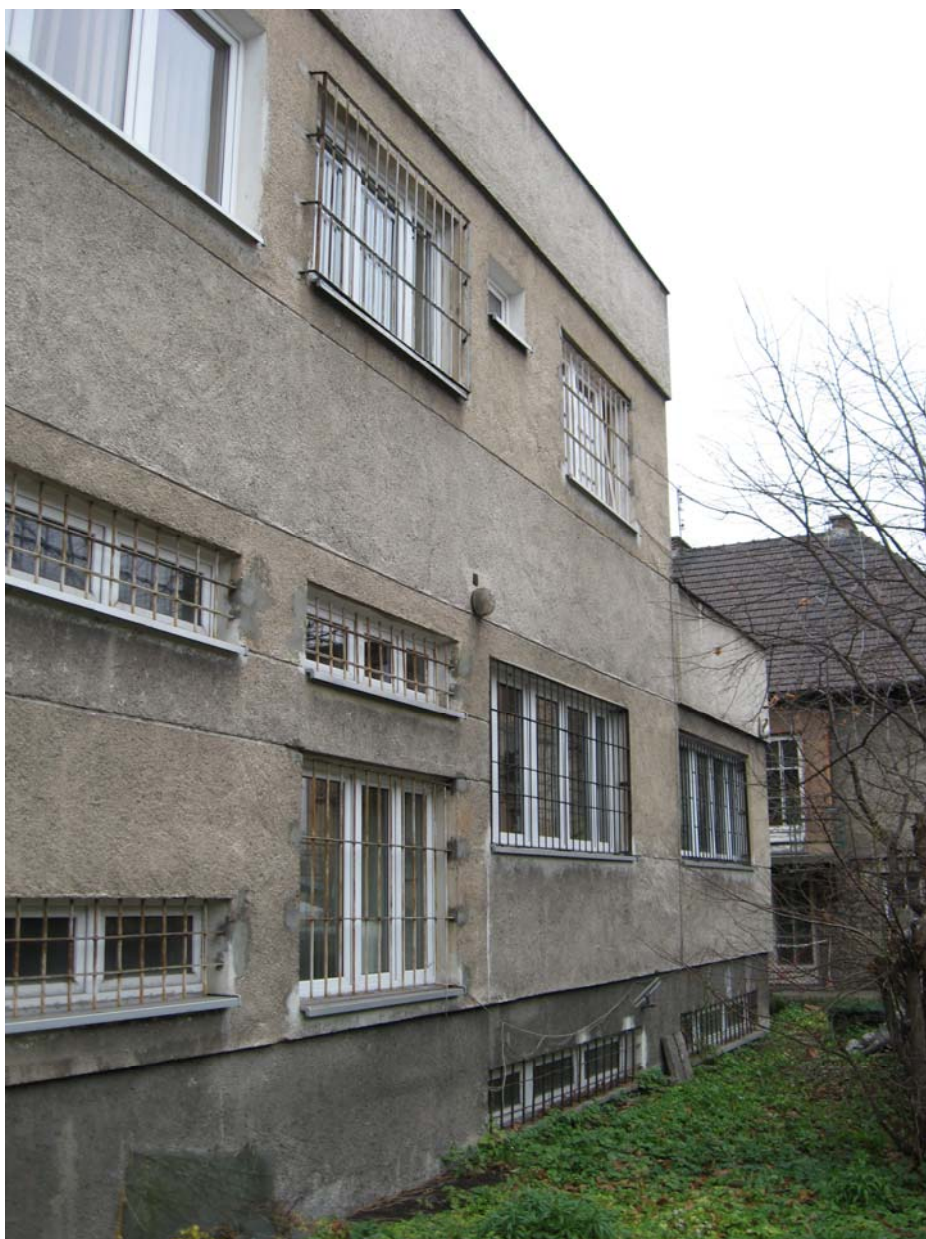
Zdjęcie nr 4. Widok na elewację wschodnią.
