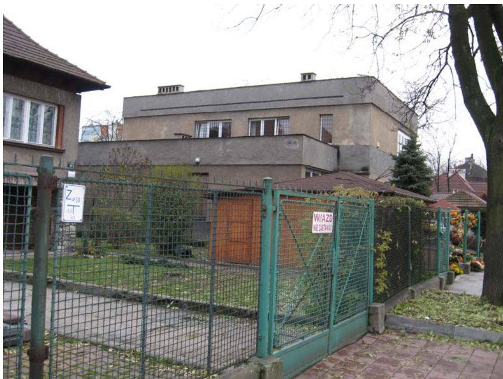
Zdjęcie nr 5. Widok na elewację północną.
