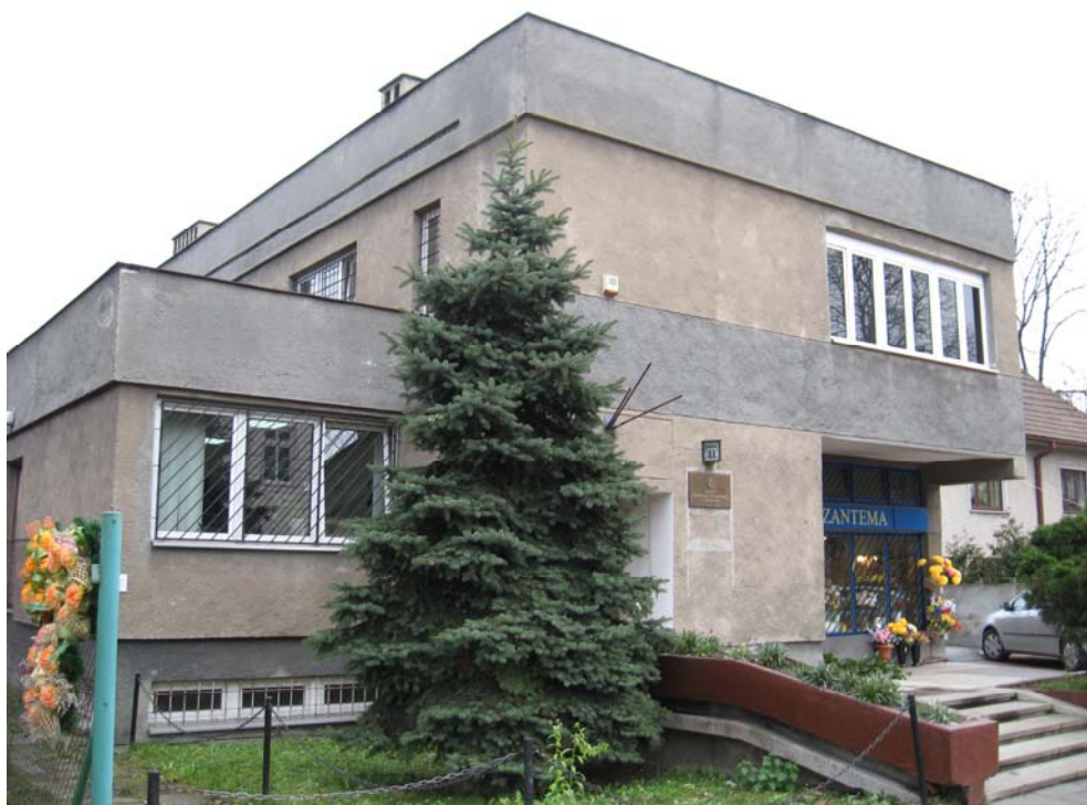
Zdjęcie nr 1, 2. Widok na elewację zachodnią.
