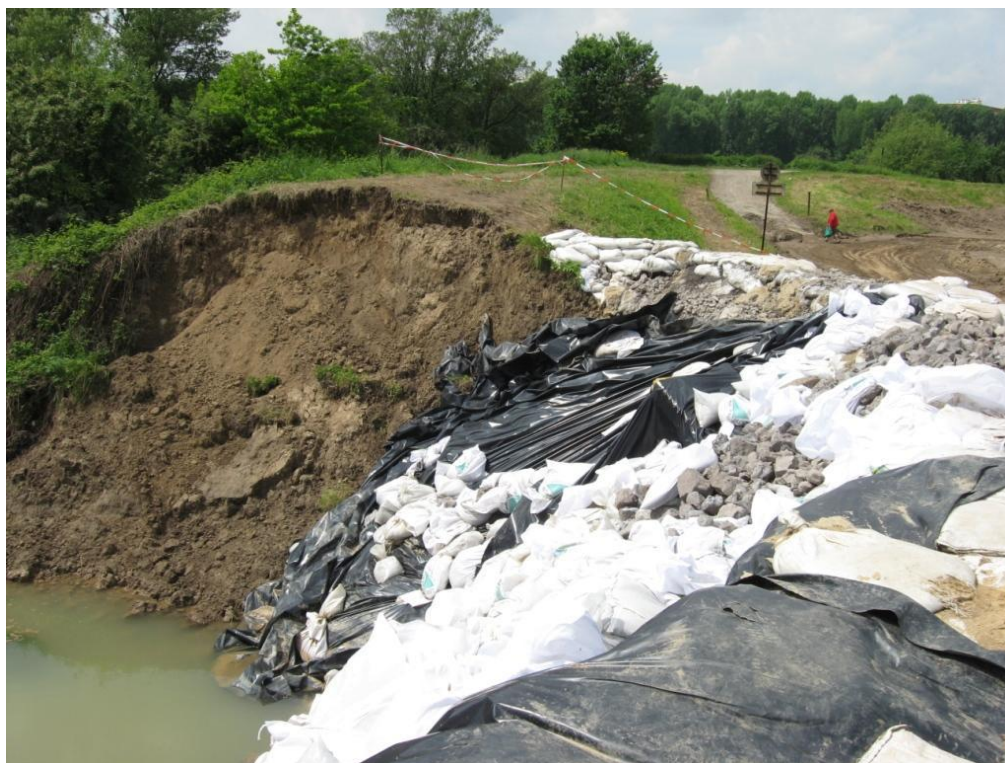
Fot. 8 Awaryjne zabezpieczenie przerwanego wału przy ul. Na Zakolu Wisły
