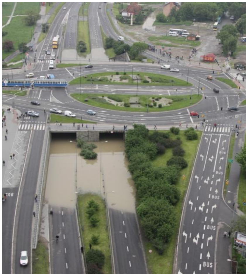
Fot. 6 Zalany wiadukt pod rondem Grunwaldzkim
