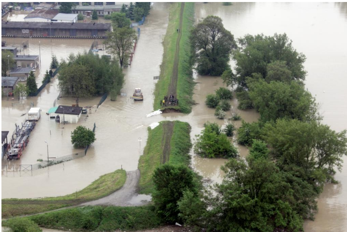
Fot. 7 Przerwane obwałowanie przy ul. Na Zakolu Wisły
