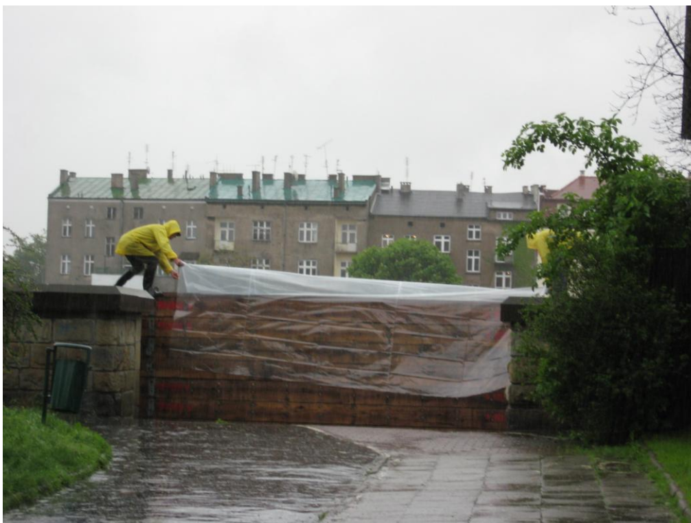
Fot. 2 Zamykanie jednej z czterech bram powodziowych
