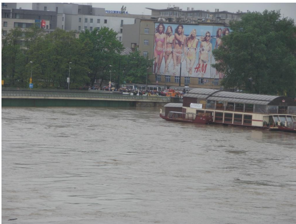
Fot. 3 Wypełnione całkowicie światło mostu Dębnickiego
