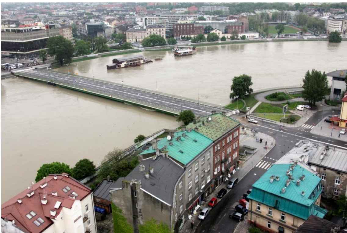
Fot. 4 Zamknięty Most Dębnicki, przegrodzony gabionami
