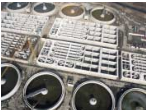
◀ Sewage Treatment Plant, Płaszów
