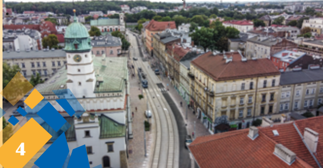
Przebudowa ul. Krakowskiej
