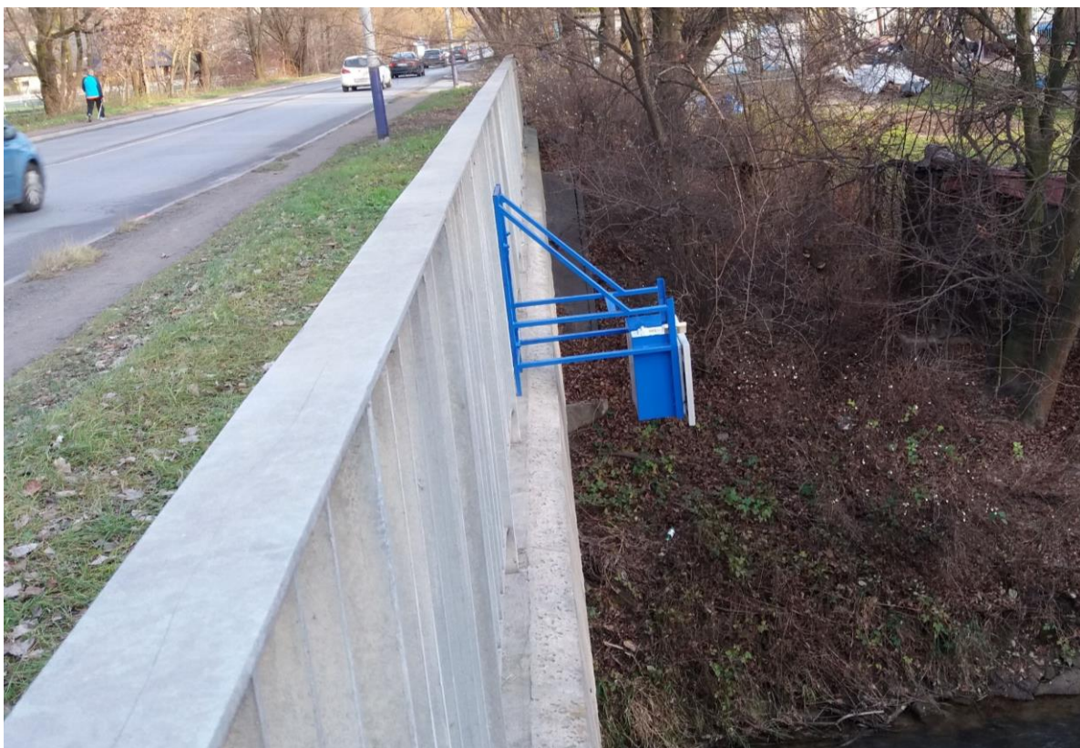
Stacja pomiarowa monitoringu powodziowego zamontowana na obiekcie mostowym na rzece Dłubni
