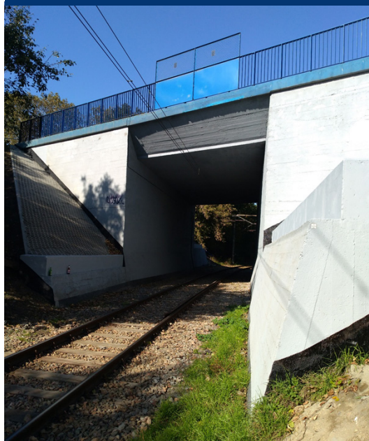
Wiadukt nad linią kolejową w ciągu ul. Nowohuckiej
