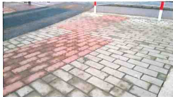
Nawierzchnia perforowana i obniżony krawężnik przy przejściu dla pieszych / przejeździe rowerowym
