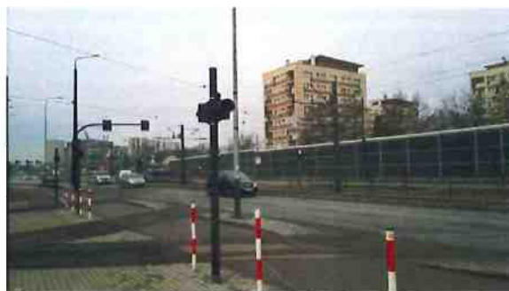
Al. Jana Pawła II – widoczne ekrany dźwiękoszczelne oraz trasa rowerowa
