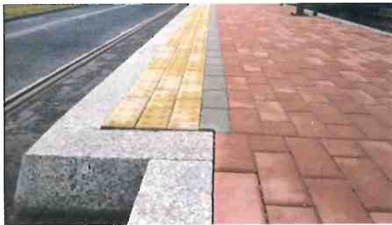
Perforowana nawierzchnia przy krawędzi przystanku, oznaczająca „strefę bezpieczeństwa”
