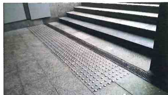
„Guziki” stanowiące nawierzchnie perforowaną przed schodami w przejściu podziemnym
