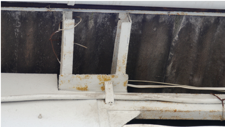
Szczegół krokwi złożonej z dwóch ceowników opartej na ryglu ściany frontowej
