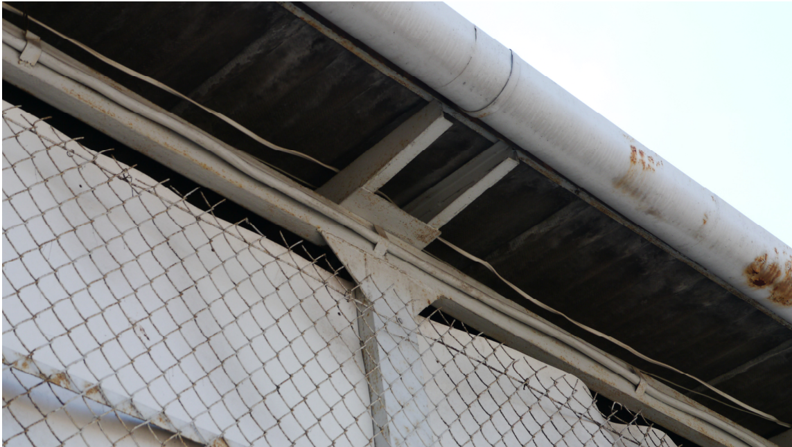
Fragment elewacji frontowej z widoczną końcówką krokwi stalowej i zakończeniem słupa, wzmocnionym usztywnieniem z trójkątnej blachy
