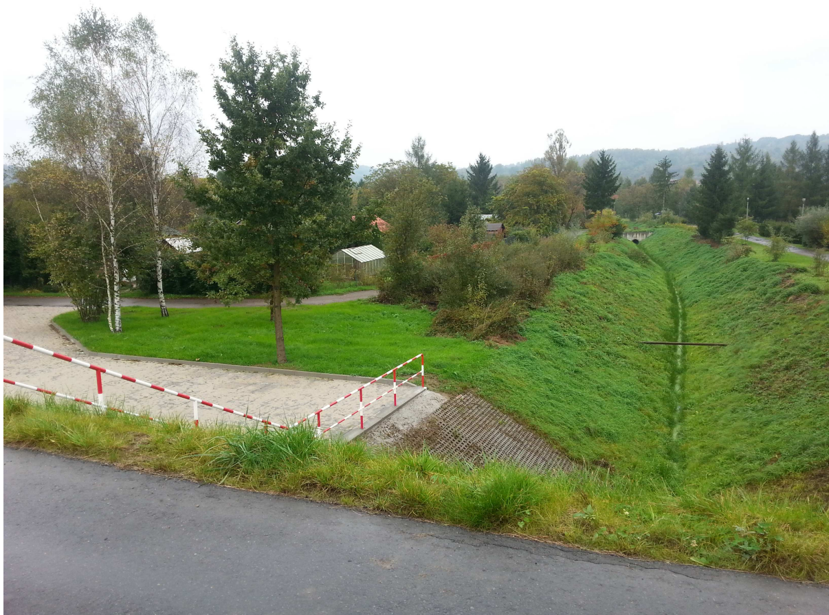
Stanowisko pompowe w rejonie ul. Rybnej
