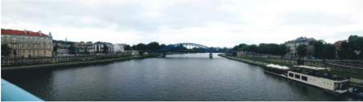
Widok na Bulwar Kurlandzki pomiędzy kładką Bernatka a mostem Piłsudskiego – z kładki Bernatka
