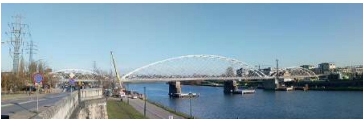
Przebudowa linii kolejowej; budowa nowych mostów na Wiśle.
