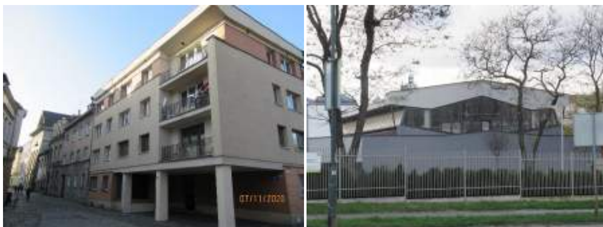
Narożny budynek mieszkalny Józefa 46//budynek stacji transformatorów na terenie Zakładu Energetycznego przy ul. Starowiślniej
