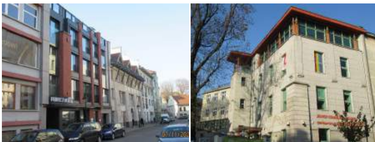
Budynki postmodernistyczne Kupa 5, 3 // Centrum Społeczności żydowskiej Miodowa 24
