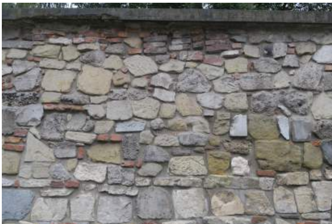
Mur cmentarza Remuh z wmurowanymi fragmentami macew zniszczonych przez Niemców w czasie okupacji.
