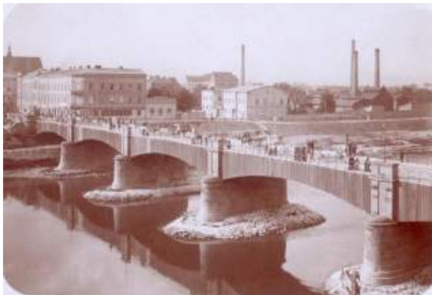
Nieistniejący most na Wiśle (ul. Mostowa); 1933
