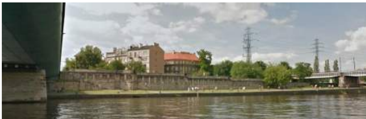
Widok na Bulwar Kurlandzki pomiędzy mostem Powstańców Śląskich a mostem kolejowym
