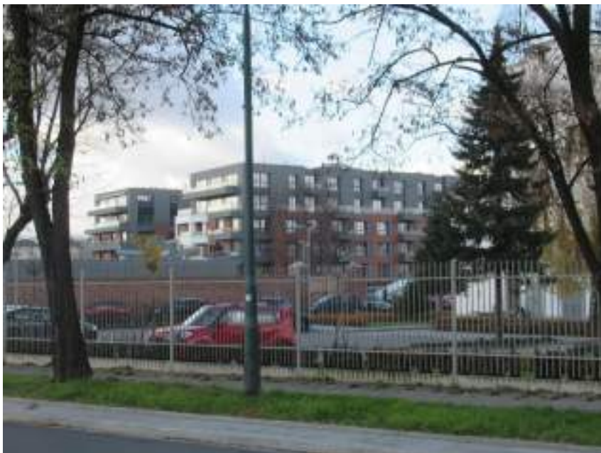
Zabudowa na terenie dawnej Gazowni
