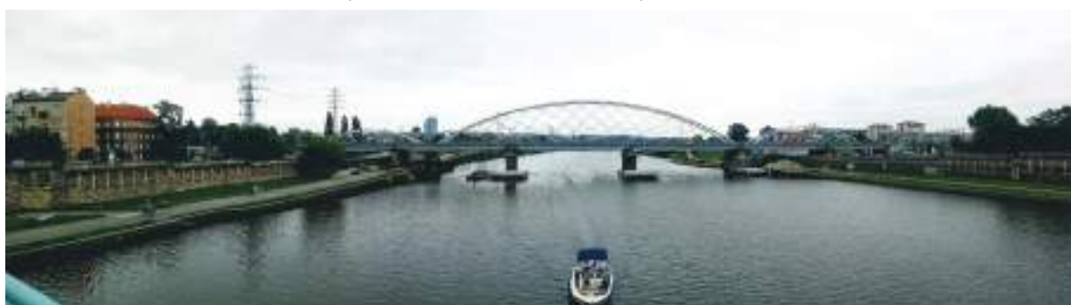
Widok na Bulwar Kurlandzki pomiędzy mostem Powstańców Śląskich a mostem kolejowym
