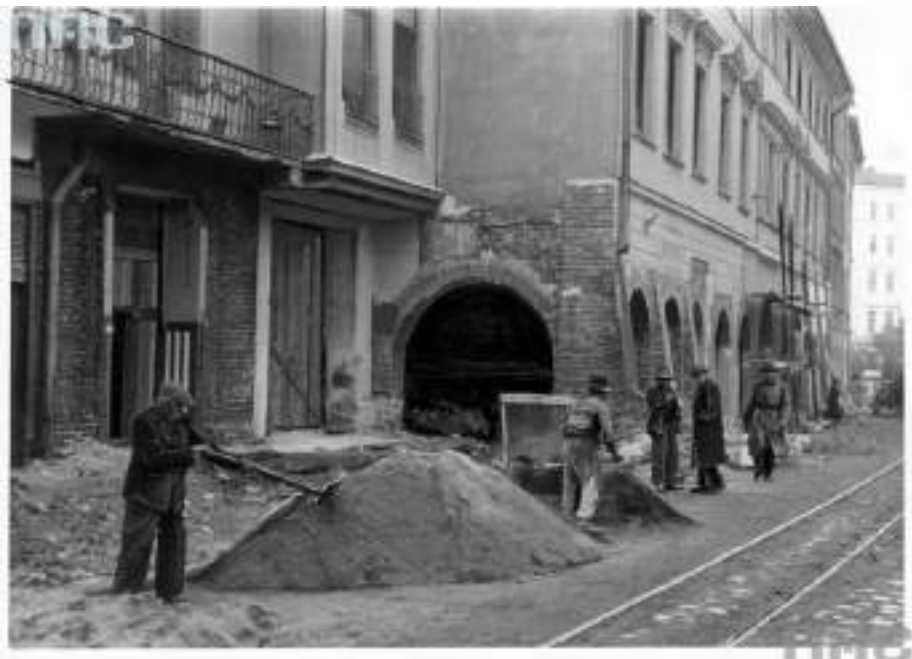
Okupacyjna przebudowa ul. Krakowskiej, (fotografia archiwalna Narodowe Archiwum Cyfrowe)
