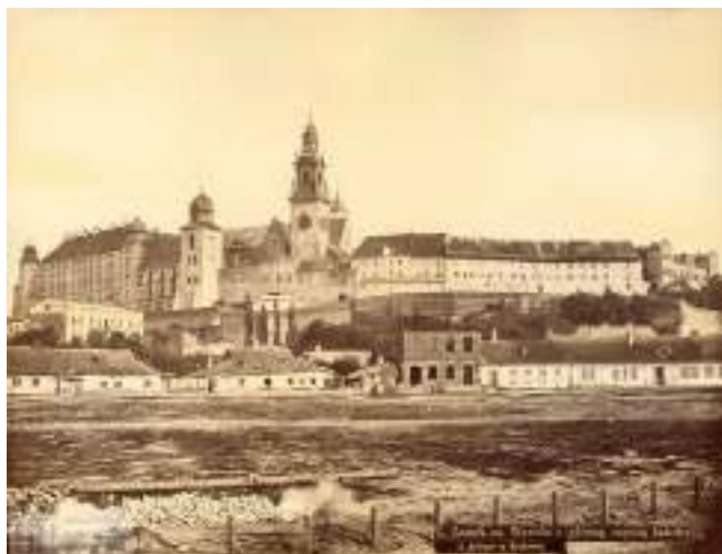
Ul. Powiśle i p. Na Groblach; stan przed 1878
