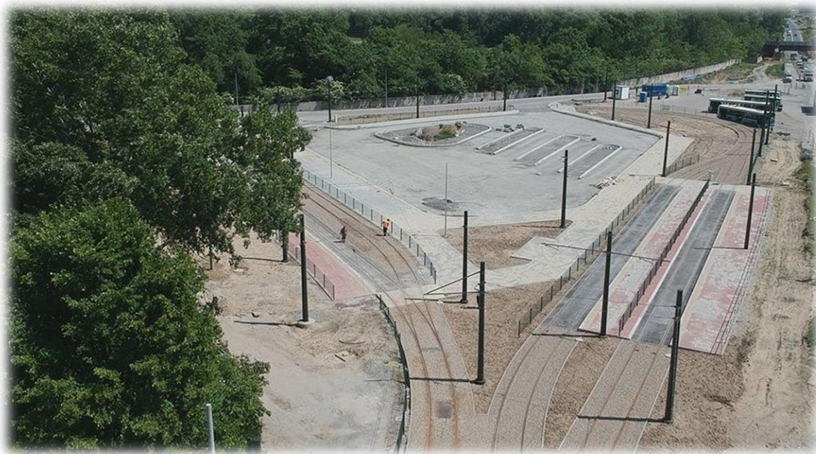
Fot. 18. Zmodernizowana pętla w Pleszowie
