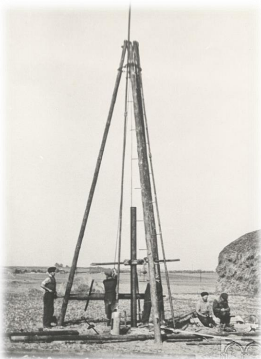
Fot. 1 Pierwsze prace przy budowie kombinatu
