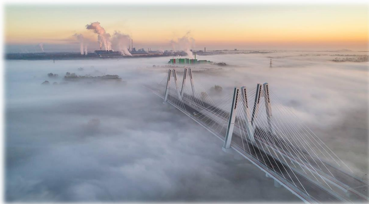
Fot. 21 Most im. Kardynała Franciszka Macharskiego w ciągu trasy S7, w tle Ekospalarnia oraz Kombinat
