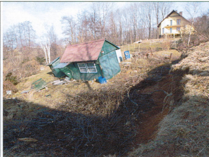
Przemieszczony budynek gospodarczy (działkowy)
