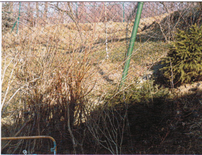
Zniszczone ogrodzenie w górnej części osuwiska
