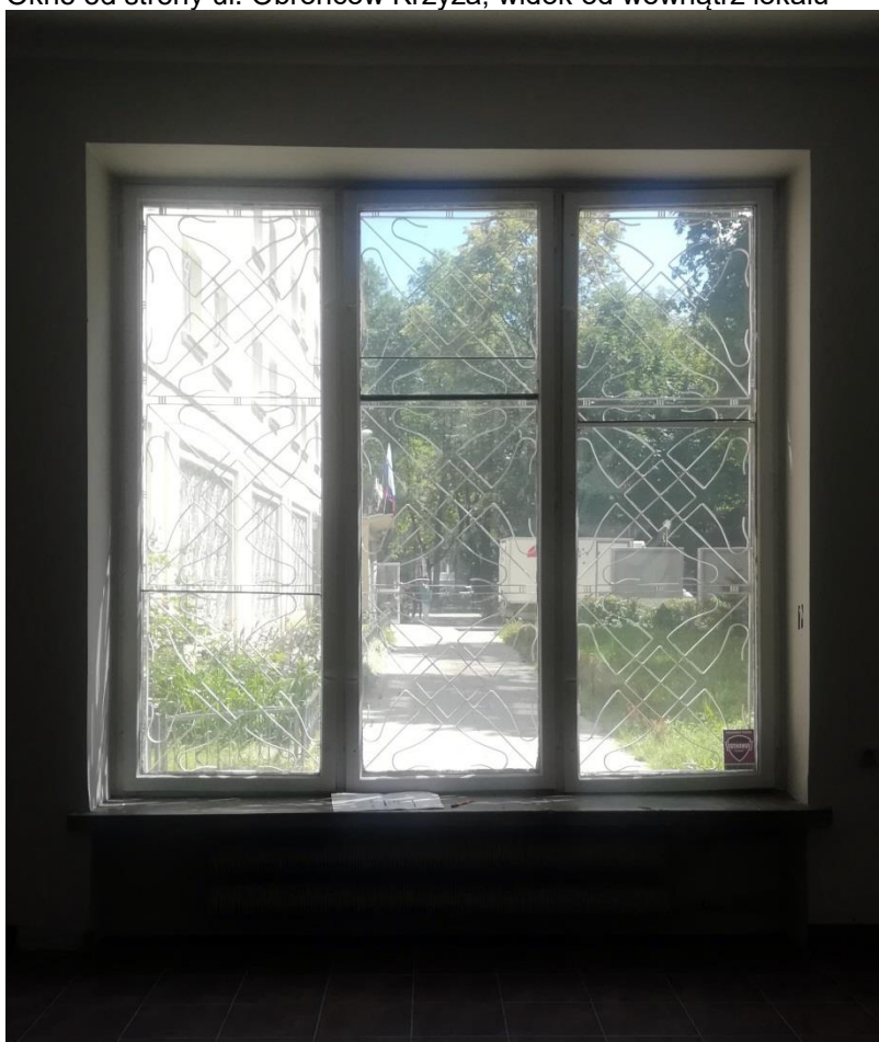
e) Okno od strony ul. Obrońców Krzyża, widok od wewnątrz lokalu
