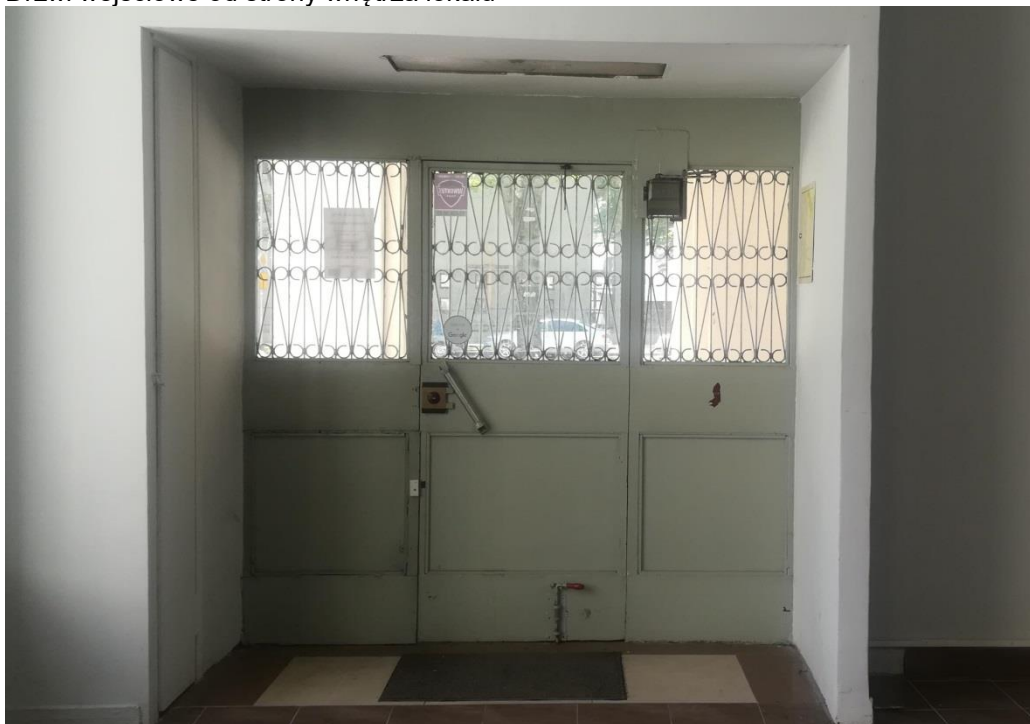
d) Drzwi wejściowe od strony wnętrza lokalu
